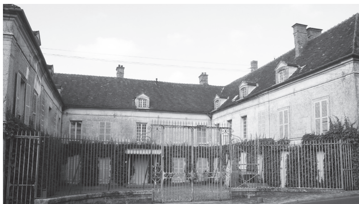
Maison Boyer à restructurer
